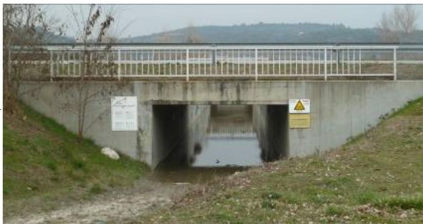
Figure 24 : Ouvrage de collecte sous l'autoroute en amont du plan d'eau
